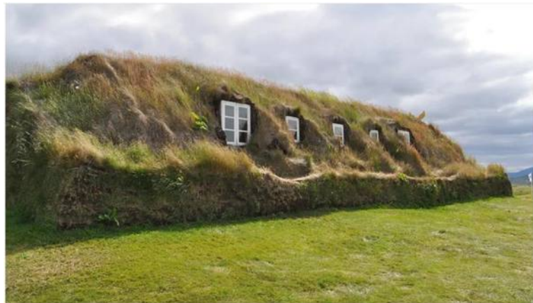
A Skógar-múzeumban belülről is megtekinthetők a gyepetős házak, melyek tetejét viking-kori technikával hőszigetelték.
